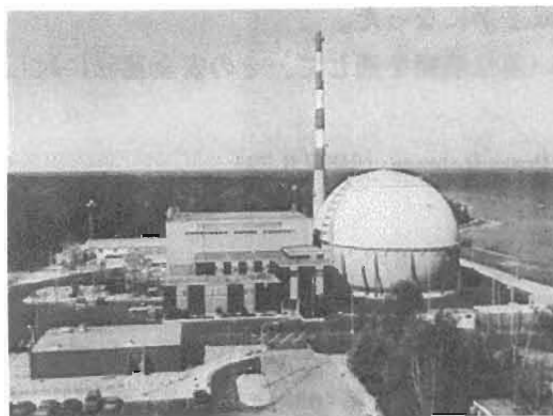
ビッグロックポイント原子力発電所の全景
