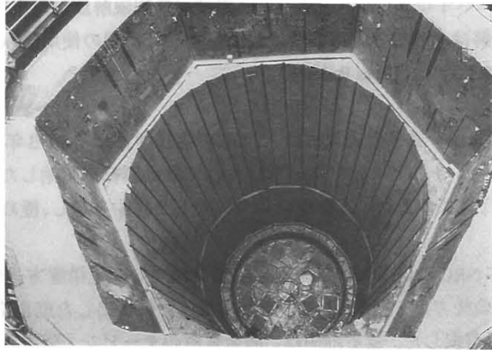
デコミッショニングが終了した生体遮蔽体を兼ねた原子炉容器（非規制部分を残したデコミッショニング）
